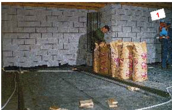
Setzen der Abziehlehren z. B. auf VERMIBIT.
