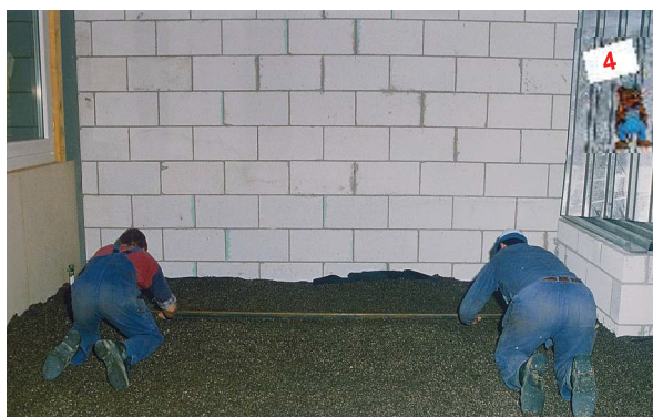
Oberflächenglattes Abziehen von VERMIBIT.
