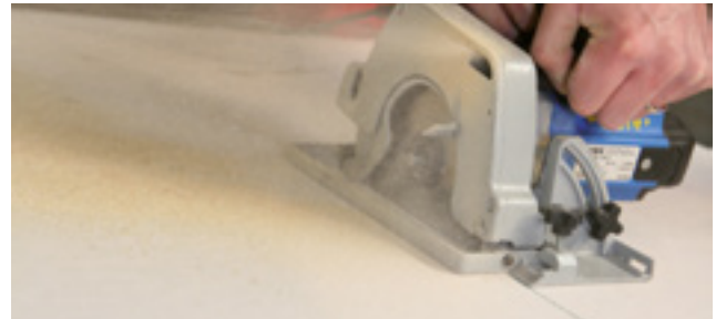
Bild Nr. 4: Zuschneiden mit der Tischkreissäge.
