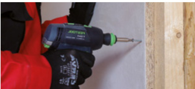
Bild Nr. 7: Befestigung mithilfe von Holzschrauben.
