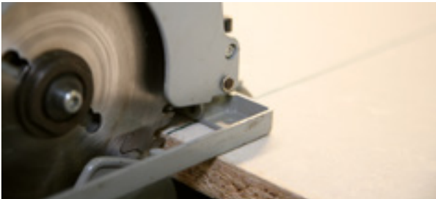
Bild Nr. 3: Zuschneiden mit der Handkreissäge.
