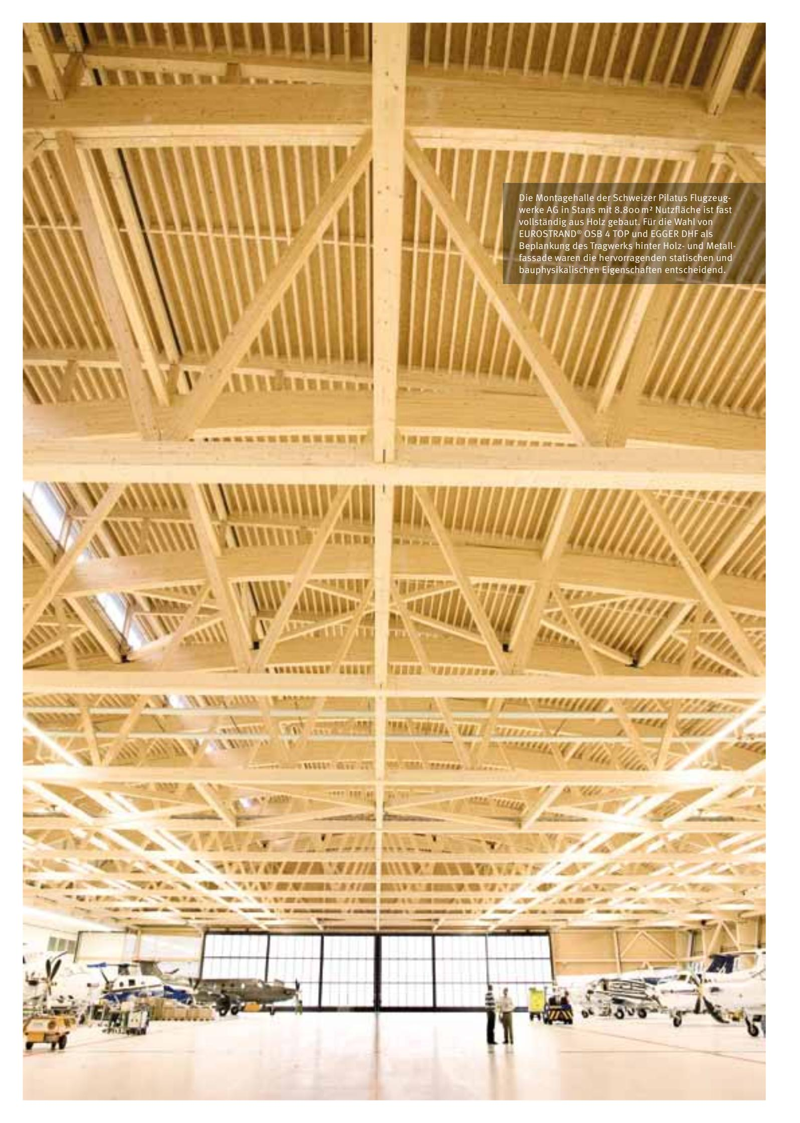
Die Montagehalle der Schweizer Pilatus Flugzeugwerke AG in Stans mit 8.800 m<sup>2</sup> Nutzfläche ist fast vollständig aus Holz gebaut. Für die Wahl von EUROSTRAND® OSB 4 TOP und EGGER DHF als Beplankung des Tragwerks hinter Holz- und Metallfassade waren die hervorragenden statischen und bauphysikalischen Eigenschaften entscheidend.
